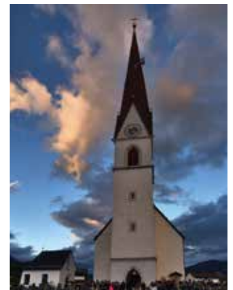
Aufgrund des schlechten Wetters am 14. September musste leider die geplante Friedhofsreinigung für 2024 abgesagt werden. Nichtsdestotrotz wurde der Tag genutzt, um den Kirchturm und die Kirche an sich wieder auf Vordermann zu bringen: Altholz und holzwurmbefallenes Altholz wurde entsorgt, der Turm bis zu den Glocken sauber gemacht, sämtliche Dekoration geordnet, fehlende Handläufe bei den Treppen angebracht, Kerzenleuchter in der Kirche sauber gemacht, Lampen getauscht, Blumenschmuck adaptiert und die Kirche wurde schlussendlich ebenso sauber gemacht.
