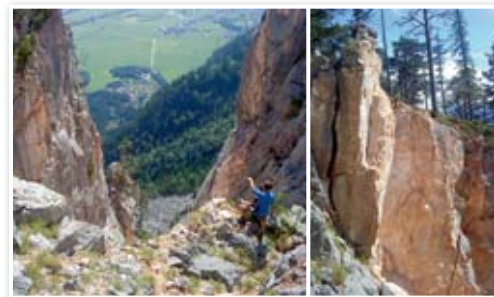
Links: Blick aus einer der Sturzrinnen auf Grünsbach, von wo aus ein kleiner Felssturz im März 2011 abge- gangen ist. Ein 300 Meter langer Wegabschnitt un- term „Rettenschöß“ ist seitdem gesperrt, da einzelne Felsblöcke den Weg übersprungen haben.
