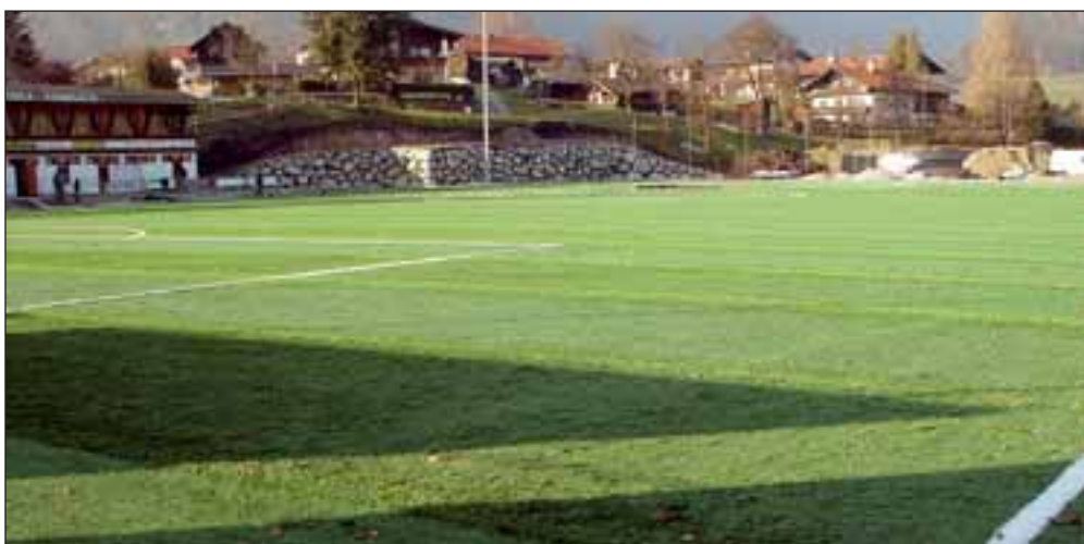
Der neue Rasen – Ende November waren die Umbauarbeiten des ersten Bauabschnittes fast beendet.
