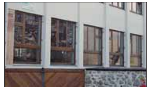
Nach dem Fenstertausch der Vollwärmeschutz.
