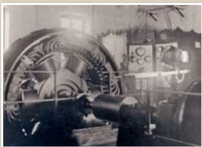
Kraftwerk Mosau, Drehstromgenerator mit Schalttafel.
