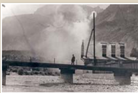
Gießerei mit Eisenbahnzufahrtsbrücke über die Ache und weiter über die Länd.
