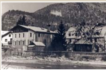
Postamt Achenrain mit Beamtenwohnung, rechts ehemaliger Getreidekasten.
