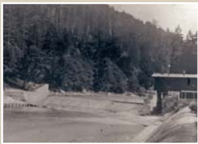
Die Wehranlage des Kraftwerks Mosau im Jahr 1917.
