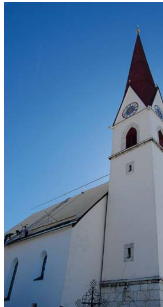
Ohne Finanzierung musste mit den Sanierungsarbeiten begonnen werden.
