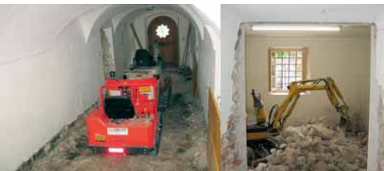
Kleinbagger nahmen das Pfarramt in Beschlag: Drei Bodenschichten wurden im Eingangsbereich abgetragen.
