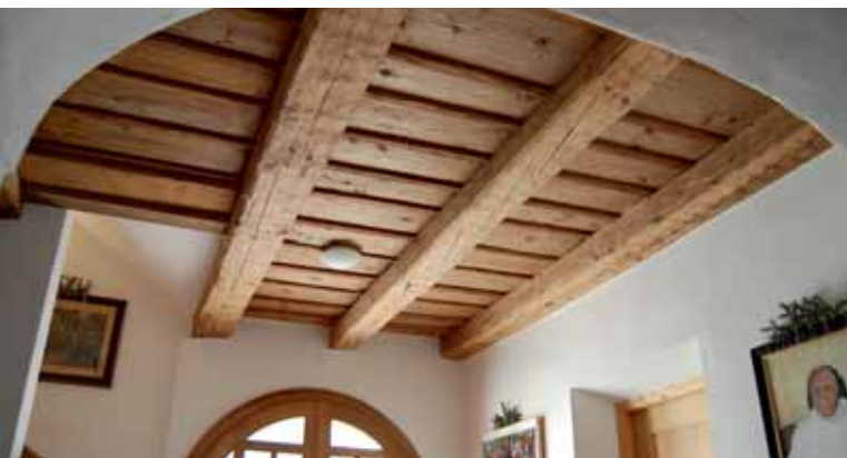
Herrliche alte Holzdecken wurden freigelegt, sorgfältig gesäubert und gebürstet.
