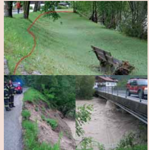
Oben: Das war knapp – gut zu sehen die Pegelhöchststände unterhalb der Duftnerbrücke. Unten links: Unterspülung der Aschauer Straße, rechts: Überwachung an der Waidachbrücke.
