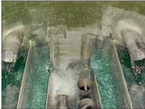
Die neue Fertigteilbrunnenstube.
