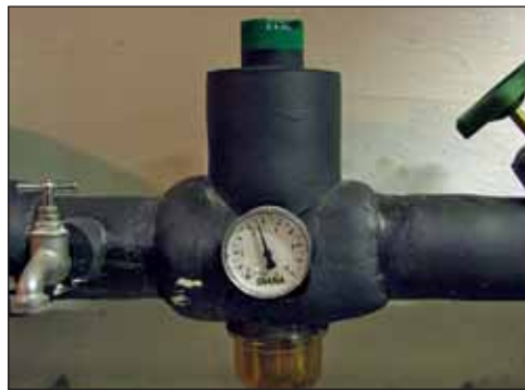
So sieht ein Druckminderungsventil aus.
