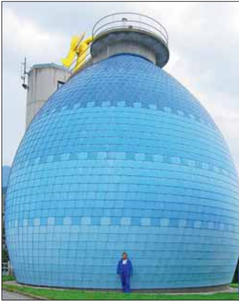
Im Faulturm wird der von den reinigenden Mikroorganismen produzierte Schlamm durch andere Bakterien weiter verarbeitet: Der resultierende Schlamm ist als Düngemittel geeignet.
