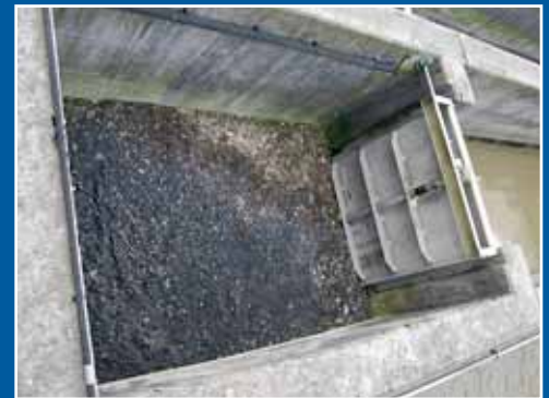
rechen, Sand- und Fettfang befreien die Abwässer von grobem Schmutz. Dann wird das Wasser
