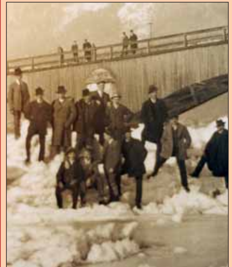
13. Februar 1929: Männer bei der Inspektion auf dem Eis des total zugefrorenen Inns vor der Rattenberger Innbrücke. Ganz rechts: Franz Haisjackl von der Innbauleitung Brixlegg.
