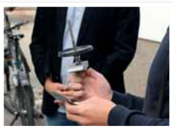
Solche Spezialschrauben, die mit der Dachhülle verflammt werden, sorgen für die Dichtheit des Daches.
