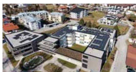
Abbildung 1 PV-Anlage am Pflege- und Betreuungszentrum (Rainer Unger, KlimaWerkstatt Alpbachtal)
